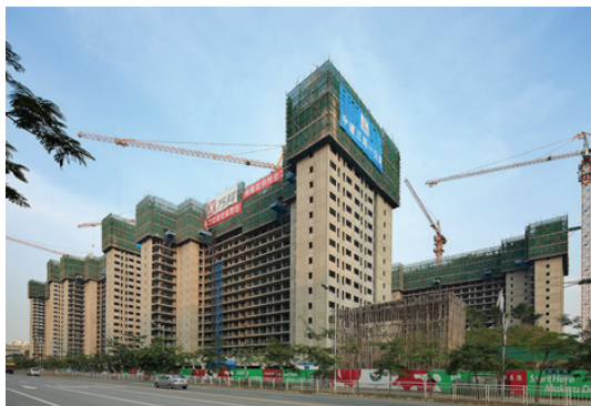
图二 龙华保障房008地块现场施工实景
