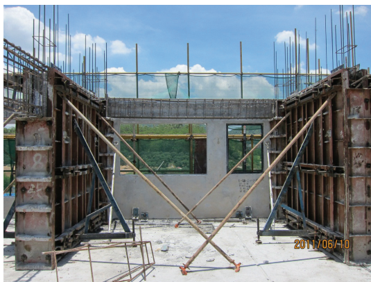
图五 主体结构墙柱大钢模施工现场实景
